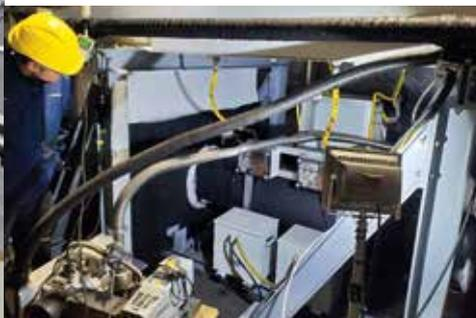
**Abb. 8 oben:** 200-kA-Modul (Bild Vision Electric SuperConductors).
