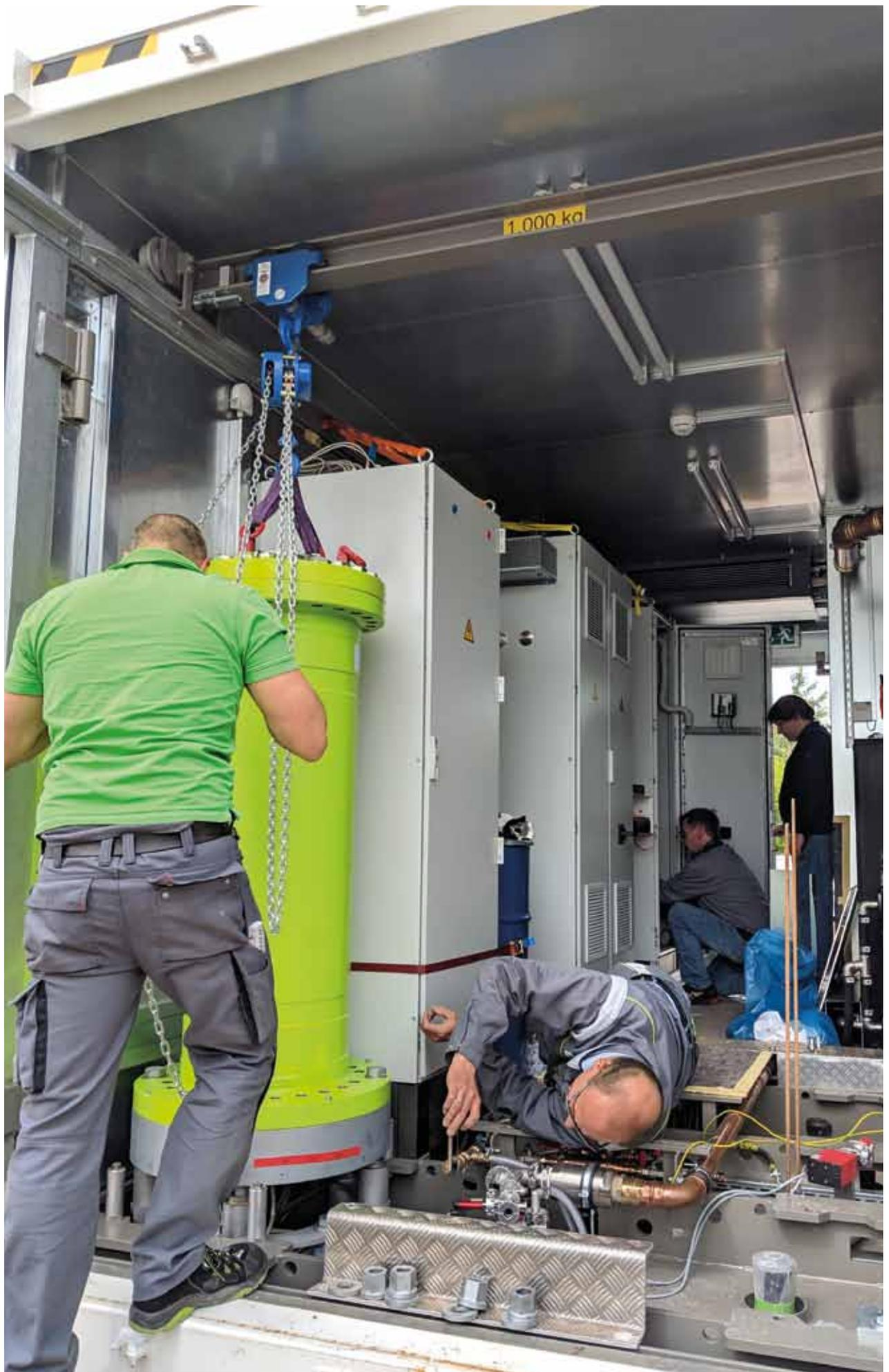
Installation eines 60 kW-3,6 kWh-Schwungmassenspeichers für das Energy Lab 2.0 am KIT.
