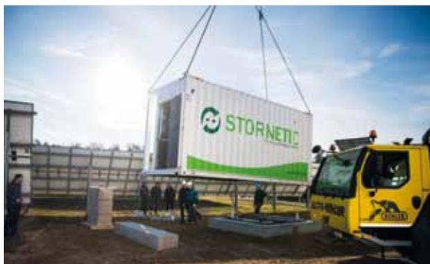
Abb. 11: Installation eines 60 kW-3,6 kWh-Schwungmassenspeichers im Energy Lab 2.0 am KIT.
