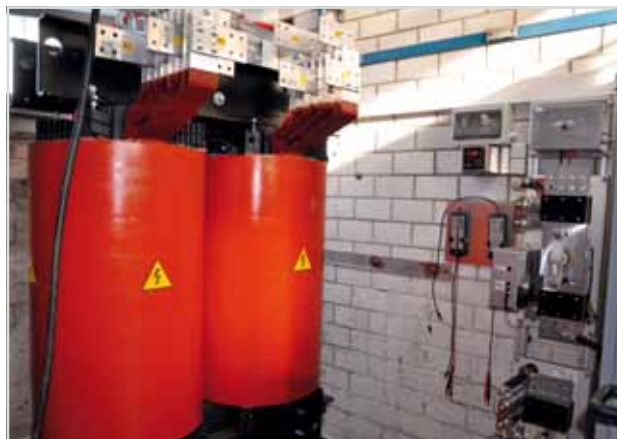
Abb. 9: Neue einphasige 1,2-MVA-Dauerlast-Kurzschlussstromtestanlage des ITEP.
