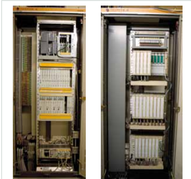
Abb. 7: Schränke für Teleperm-AS488 und Simatic-S5.
