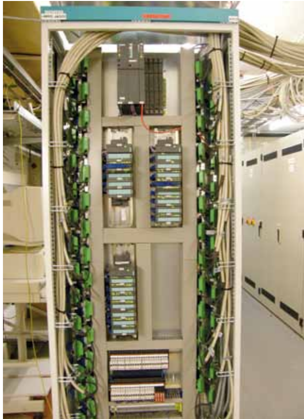
Abb. 10: Neue Steuerung Simatic PCS7-AS417 mit analogen und digitalen E/A-Peripheriebaugruppen.
