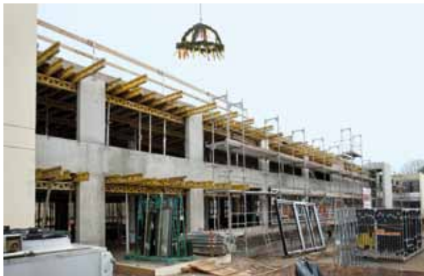
Richtfest am Ersatzbau für das Bürogebäude Bau 410.
