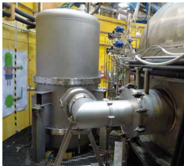
Abb. 2: Testkryostat für den Test der W7-X Prototypstromzuführungen an TOSKA.
