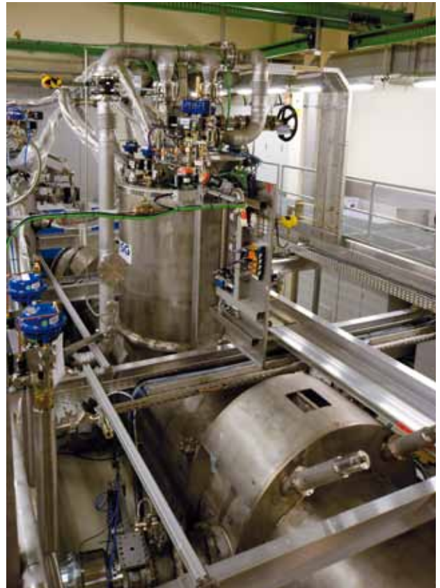
Abb. 9: Blick auf die DPS nach Montage aller Verbindungsleitungen (beispielsweise zur Kryotransferleitung).
