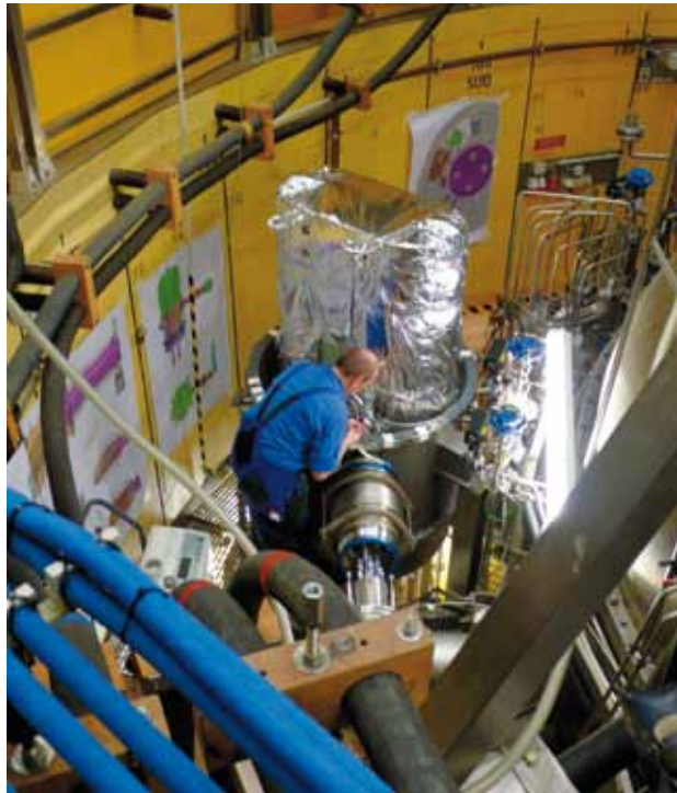
Abb. 2: Installation und Anschluss an B300.
