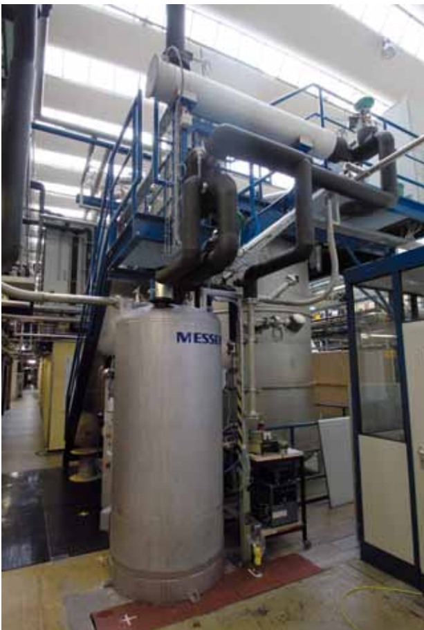
Abb. 4. Die neue 100 K-Anlage für TIMO-2 – bereit für die PPC-Tests.
