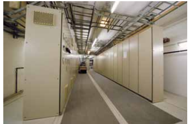
Abb. 8: Blick in den Automatisierungsraum des TLK mit den alten Automatisierungsschränken.
