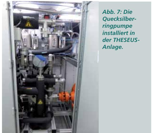
Abb. 7: Die Quecksilberringpumpe installiert in der THESEUS-Anlage.
