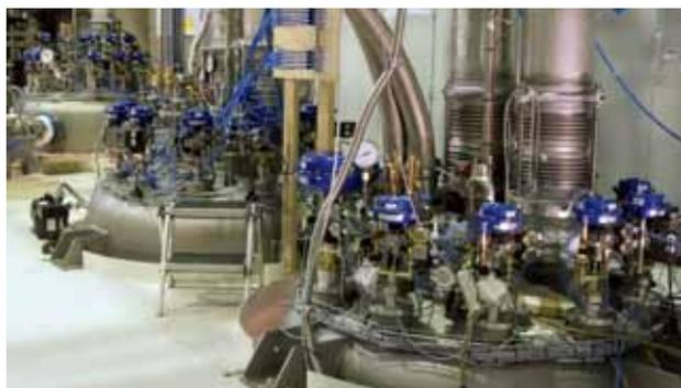
Abb. 3: Ventilbox (rechts), Kontrollkryostat (Mitte) und zweite Ventilbox (hinten links) in der Testanlage CuLTKa.
