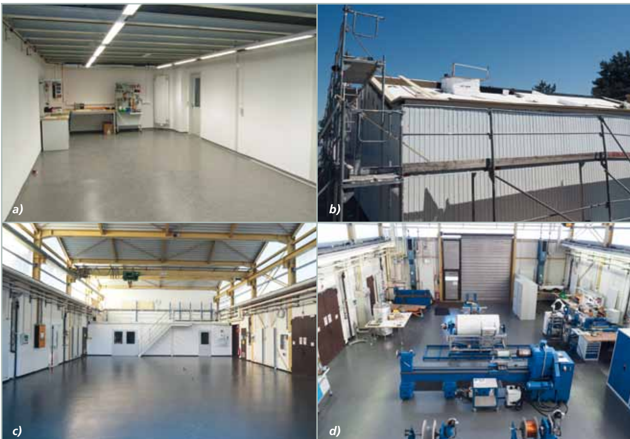
Abb. 1a-1d: Sanierung von Bau 257 – Arbeiten im 1. Bauabschnitt. Umbau der Stahlbühne mit Neuschaffung eines abgeschlossenen Arbeitsbereichs, energetische Sanierung des Sheddachs mit Seitenwänden, Bodenarbeiten und Teilinbetriebnahme.
