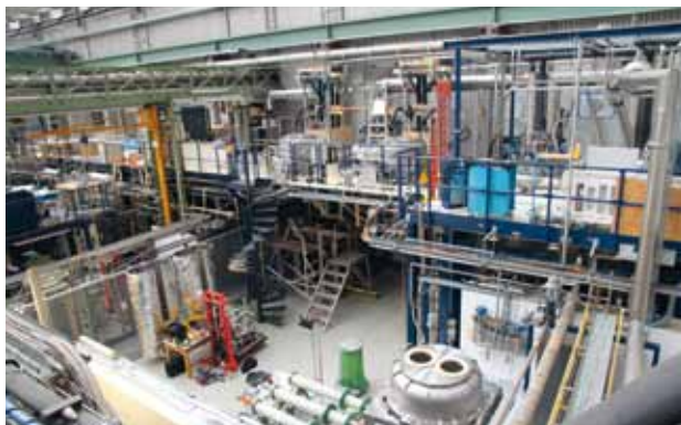
Abb. 4: Die CuLTka-Testanlage nach dem Ausbau von vier Stromzuführungen.
