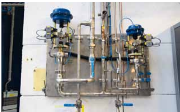
Abb. 5: Verbesserte He-Reingastrückführung zur 2 kW-Kälteanlage.
