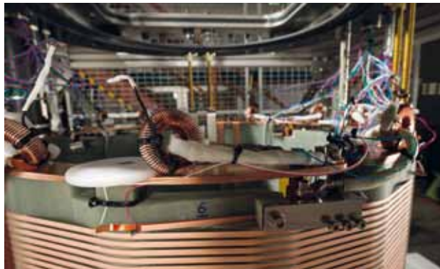
Abb. 15: Oberseite der supraleitenden Wicklung mit Anschlüssen und Sensorik, beispielsweise Rogowski-Spulen zur Strommessung.
