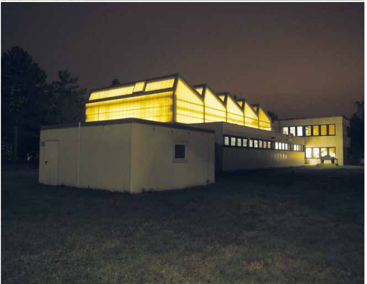
Bau 257 mit HFM-Technikum: energetische Sanierung des Sheddachs mit Neugestaltung der oberen Seitenwände.
