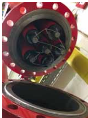
Abb. 3: Filterkerzenwechsel an Koaleszer F1351 – 2 kWTTA.
