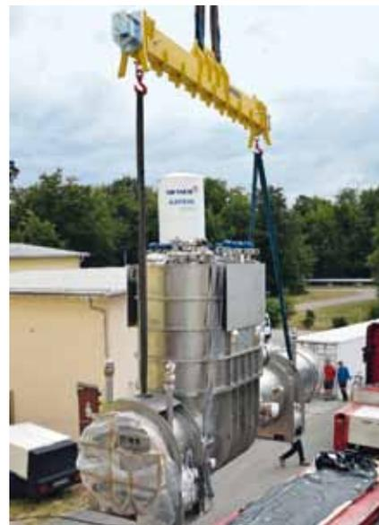
Abb. 4: Einbringung der CPS in das Tritiumlabor Karlsruhe.
