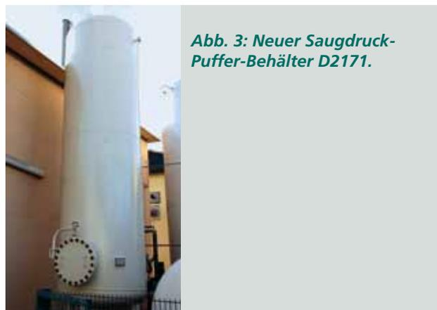
Abb. 3: Neuer Saugdruck-Puffer-Behälter D2171.
