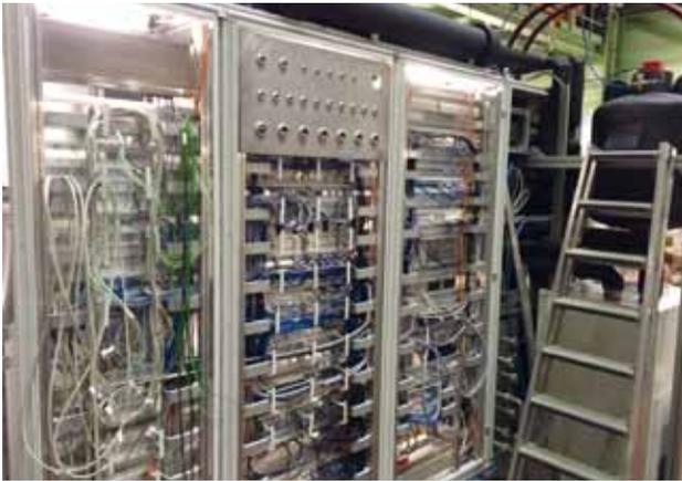
Abb. 2: Schaltschrankmontage des JET-Pumpstands.
