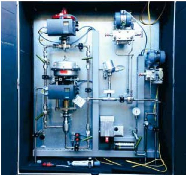
Abb. 1: Aufbau des Armaturenschranks der He-Rückgewinnungsanlage.
