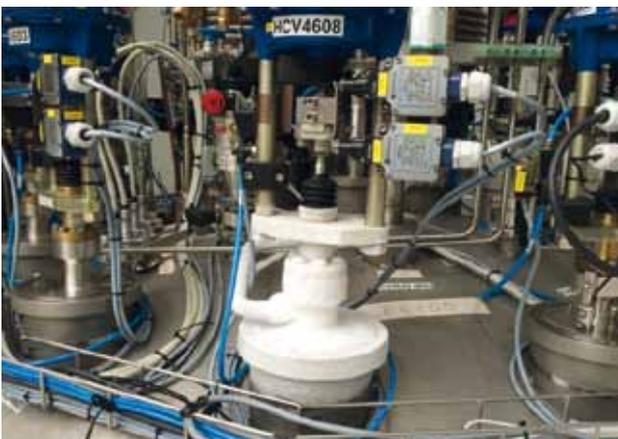
Abb. 8: Eingefrorenes Ventil durch Oszillationen im Kryosystem.
