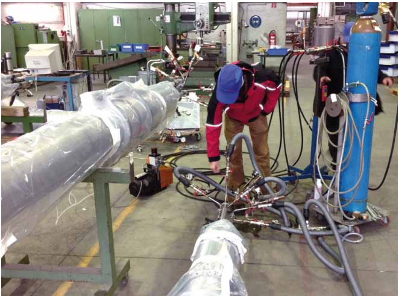
Abb. 8: Abnahmetest der Transferleitungen bei Cryotherm.
