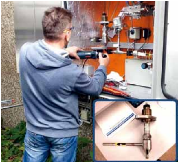
Abb. 1: Instandsetzungsarbeiten am Hochdruckventil zwischen Helium-Reinigung und Reinspeichern.
