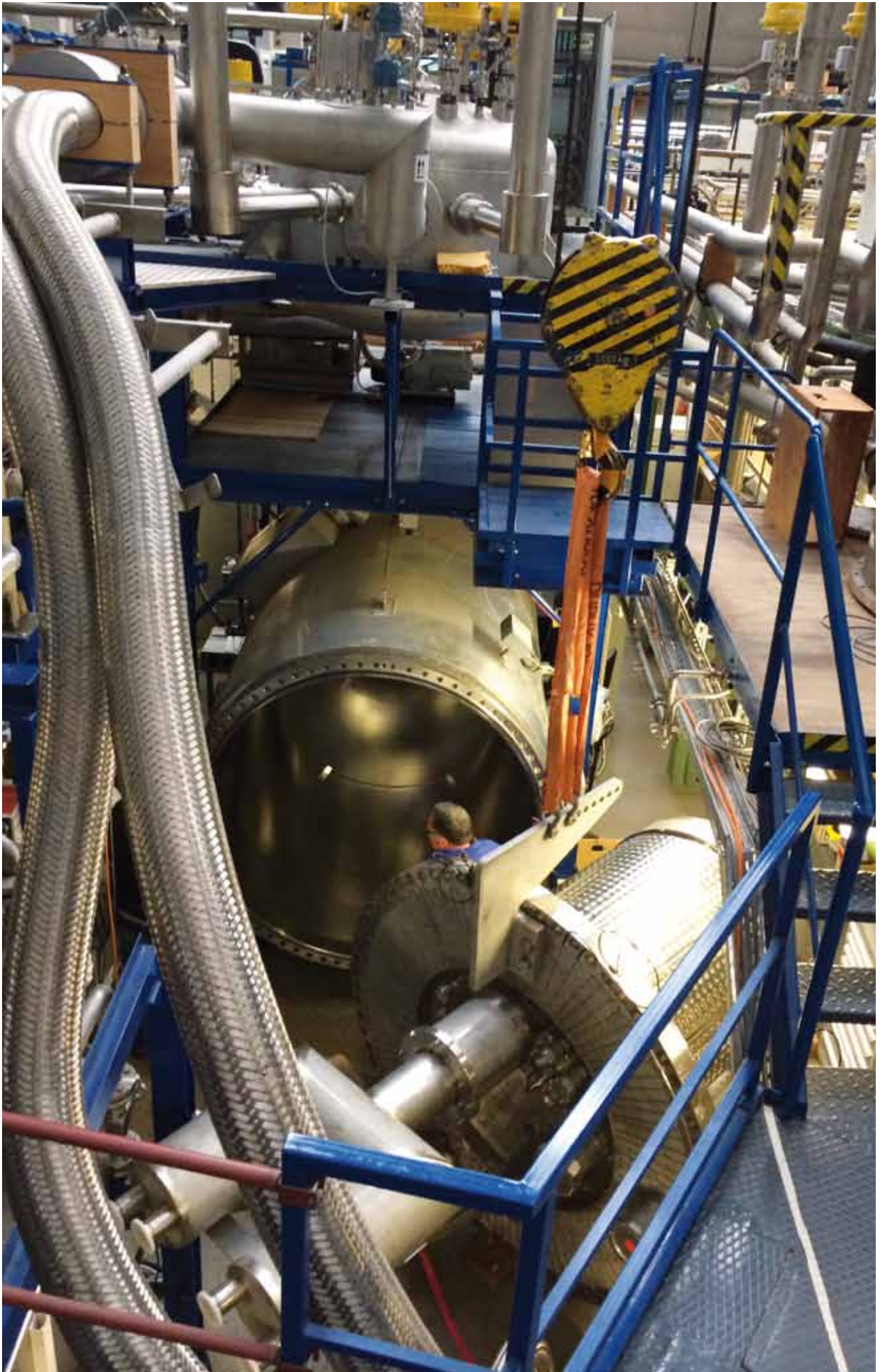
Maßarbeit beim Einbau des neuen Testeinbaus in TIMO-2.
