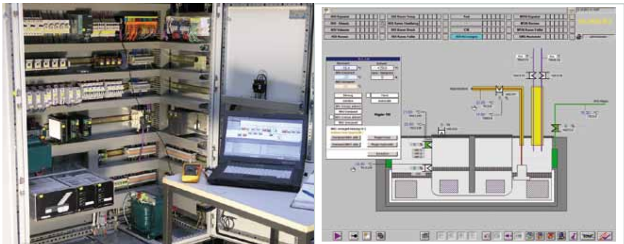
Abb. 3: Neue MSR-Steuerung der Heizungen der HOMER I-Anlage: links der Steuerschrank, rechts die Bedienoberfläche von WinCC.
