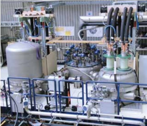
Abb. 9: Eingebaute JT-60SA Stromzuführungen.
