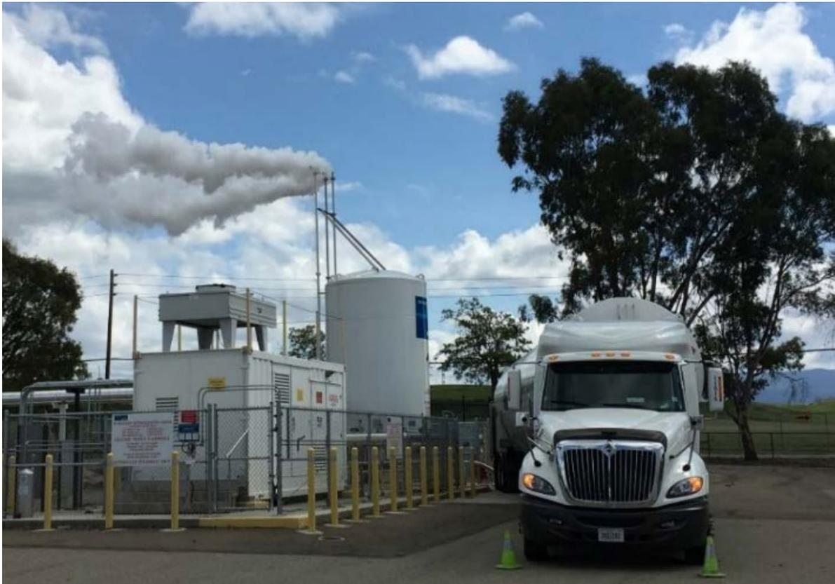
Abbildung 6.2: Abfuhr von verdrängtem gasförmigen Wasserstoff über den Kamin des Speichertanks bei der LH<sub>2</sub>-Anlieferung. Durch die Kälte des abgeführten Gases kondensiert örtlich Feuchtigkeit aus der Luft und es bildet sich eine Nebelwolke.
