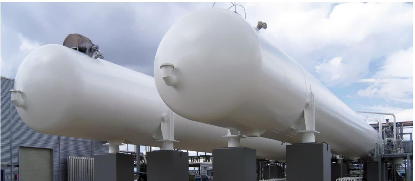
Abbildung 5.6: Zylindrische LH<sub>2</sub>-Tanks am Wasserstoffverflüssiger in Leuna, Deutschland. Quelle: Linde
