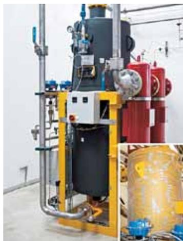
Abb. 6: Heizungsregelung und Isolierarbeiten am Aktivkohle-adsorber der 500 W Tieftemperaturanlage.
