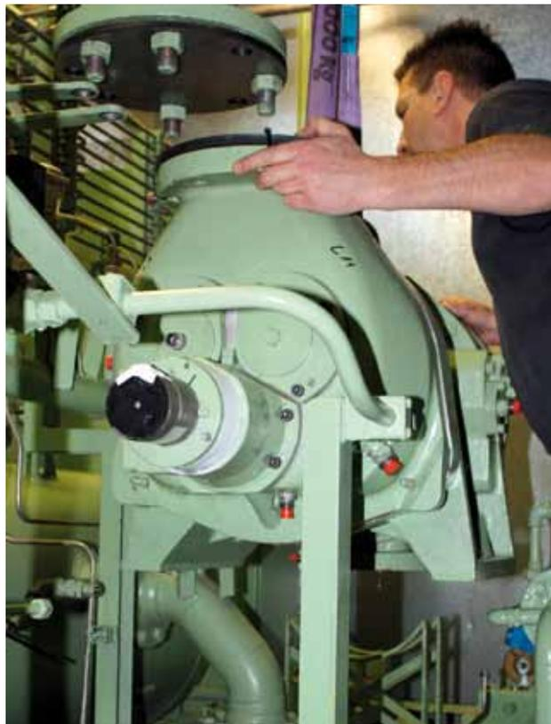
Abb. 5: Ausbau des He-Schraubenkompressors V3 der 2-kW-He-Tieftemperaturanlage für die Revision.
