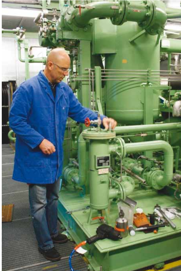
Abb. 7: Ölfilterwechsel am ölgedichteten He-Schraubenkompressor der 2-kW-He-Tiefemperaturanlage.
