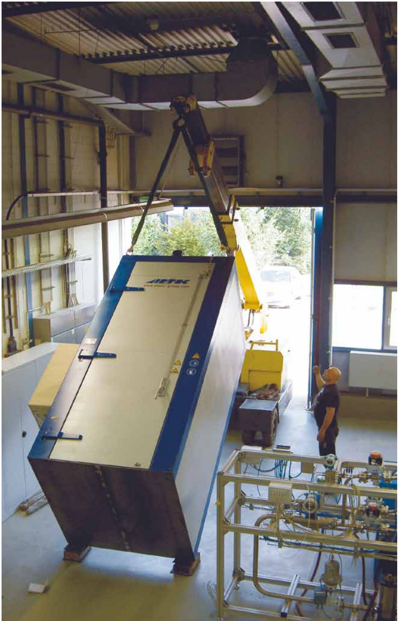
Der Ofen für die neue Beschichtungsanlage wird aufgestellt.
