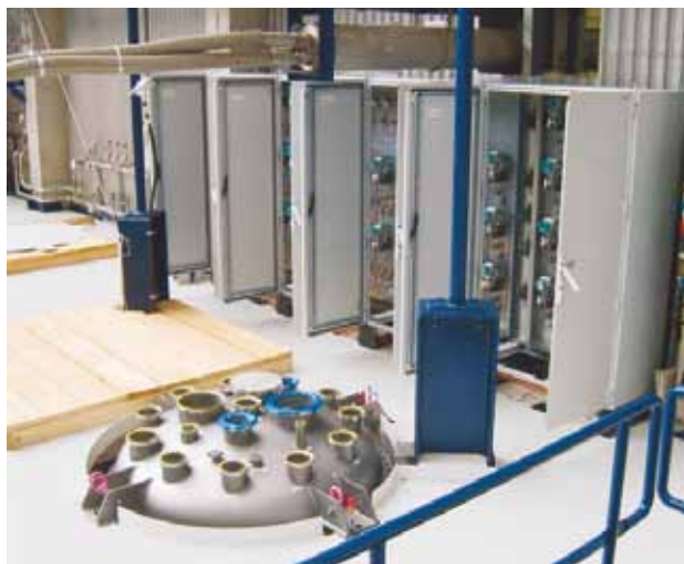
Abb. 2: Testanlage CuLTka im Aufbau für den Serientest der JT-60SA Stromzuführungen.
