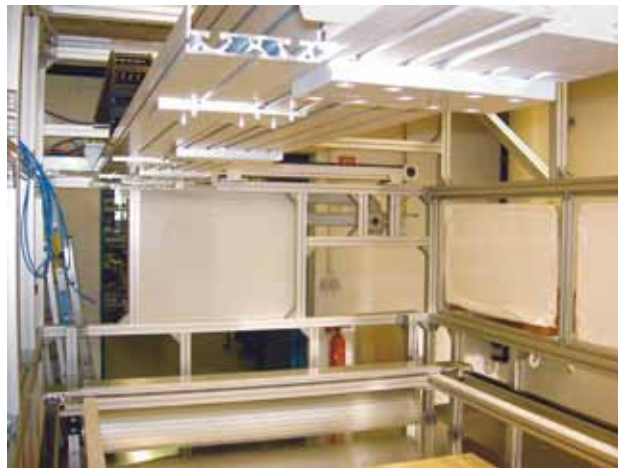
Abb. 4: Die neue Beschichtungsanlage entsteht.
