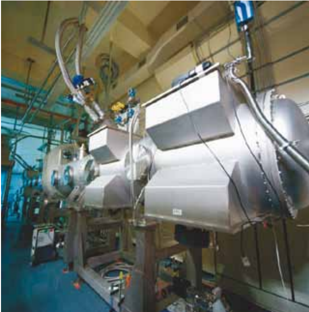
Abb. 8: Demonstrator im TLK zur Erprobung der WGTS Strahlrohrkühlung.
