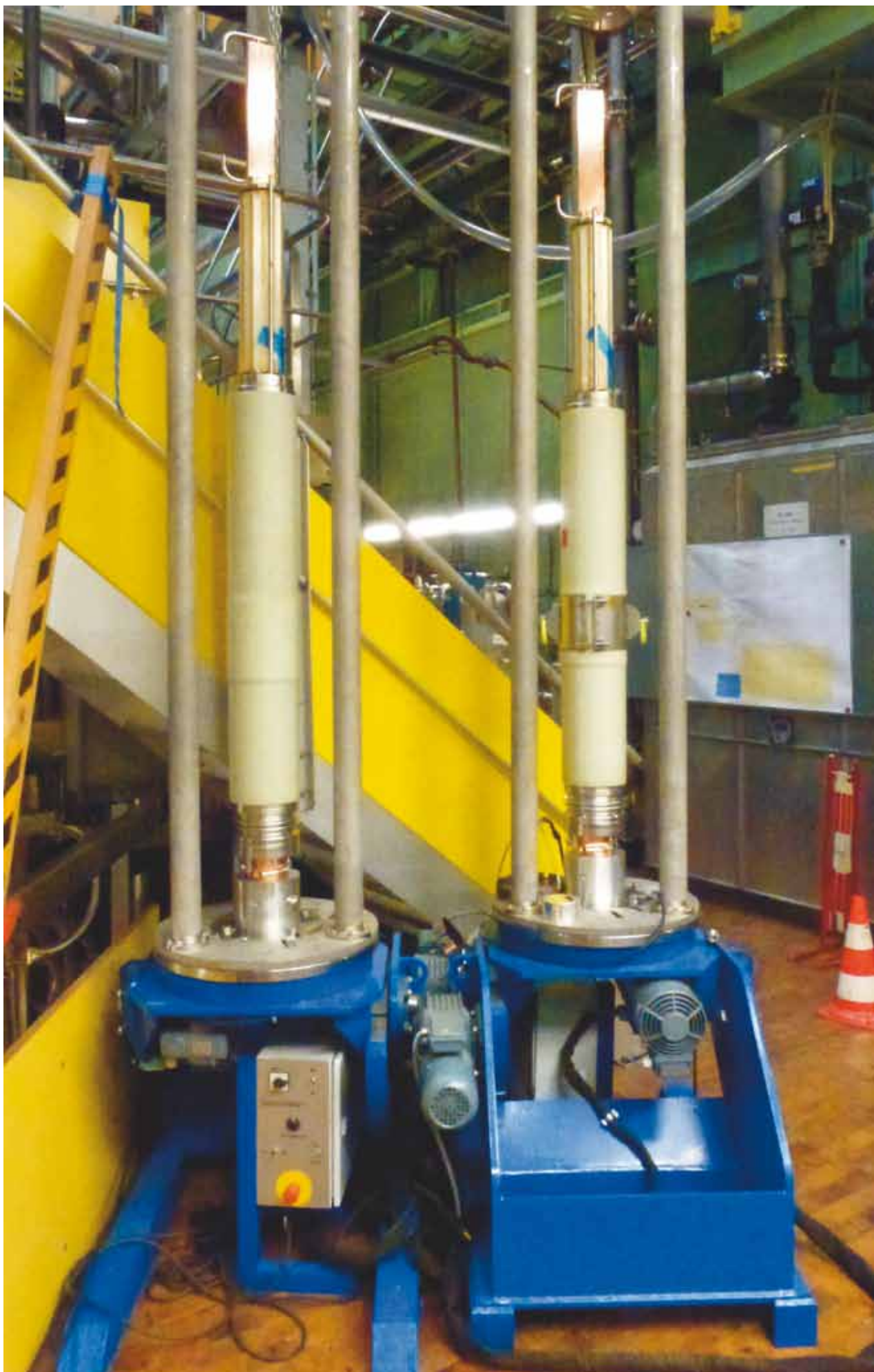
Stromzuführungen für W7-X, vorbereitet zum Anlöten des kalten Kontaktes.
