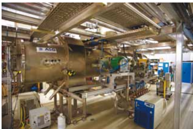
Abb. 3: DPS2-F. Blick auf die Pumpkammern 2 und 3.
