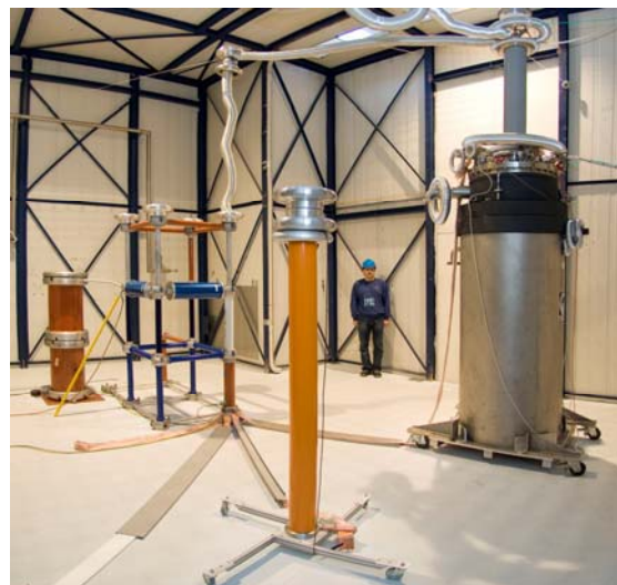
Abb. 4: Neue Prüfhalle des kryogenen Hochspannungslabors
