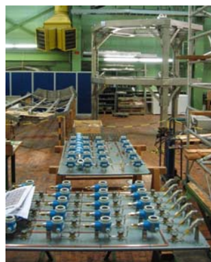
Abb. 6: MSR-Schränke in Vorbereitung für neue MSR-Technik. Im Hintergrund Spulengestelle (IPP)
