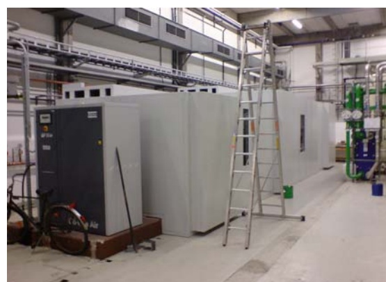
Abb. 2: Neue Schallhaube für Rückverdichtungsanlage
