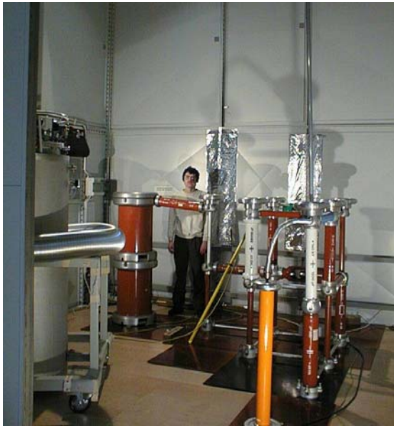
Abb. 21: Das Tieftemperatur- Hochspannungslabor
