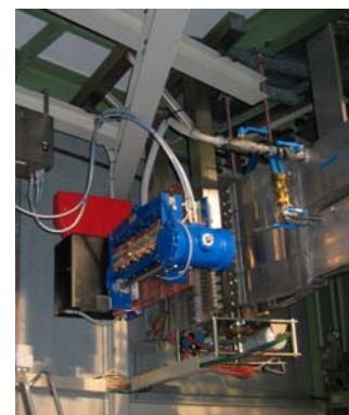
Abb. 7: Neue Hochstromschalter; neue Datenerfassung im Aufbau; QD System und Elektronik werden überholt.
