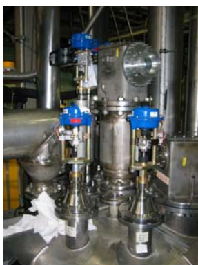
Abb. 5: Neue Ventile am B250 als Beispiel für die Überholung der Kryo- und Vakuumtechnik bei TOSKA
