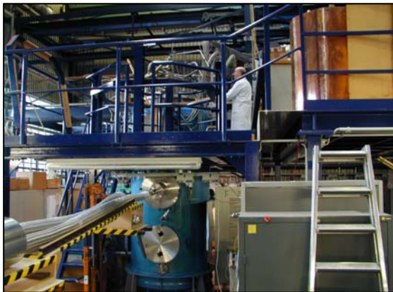
Abb. 29: THISTA-Anlage zur Untersuchung thermischer Isolationen (Beispiel: Test der Kryohülle eines supraleitenden Energieübertragungskabels)
