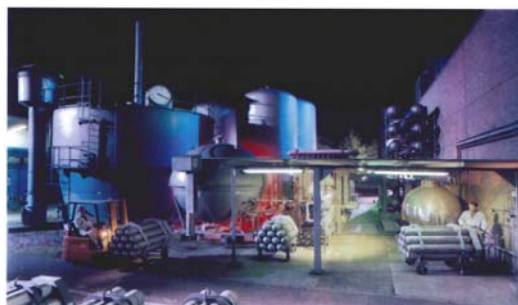
Abb. 28: Die He-Kälteanlage für 2 kW äquivalent bei 4,5 K
