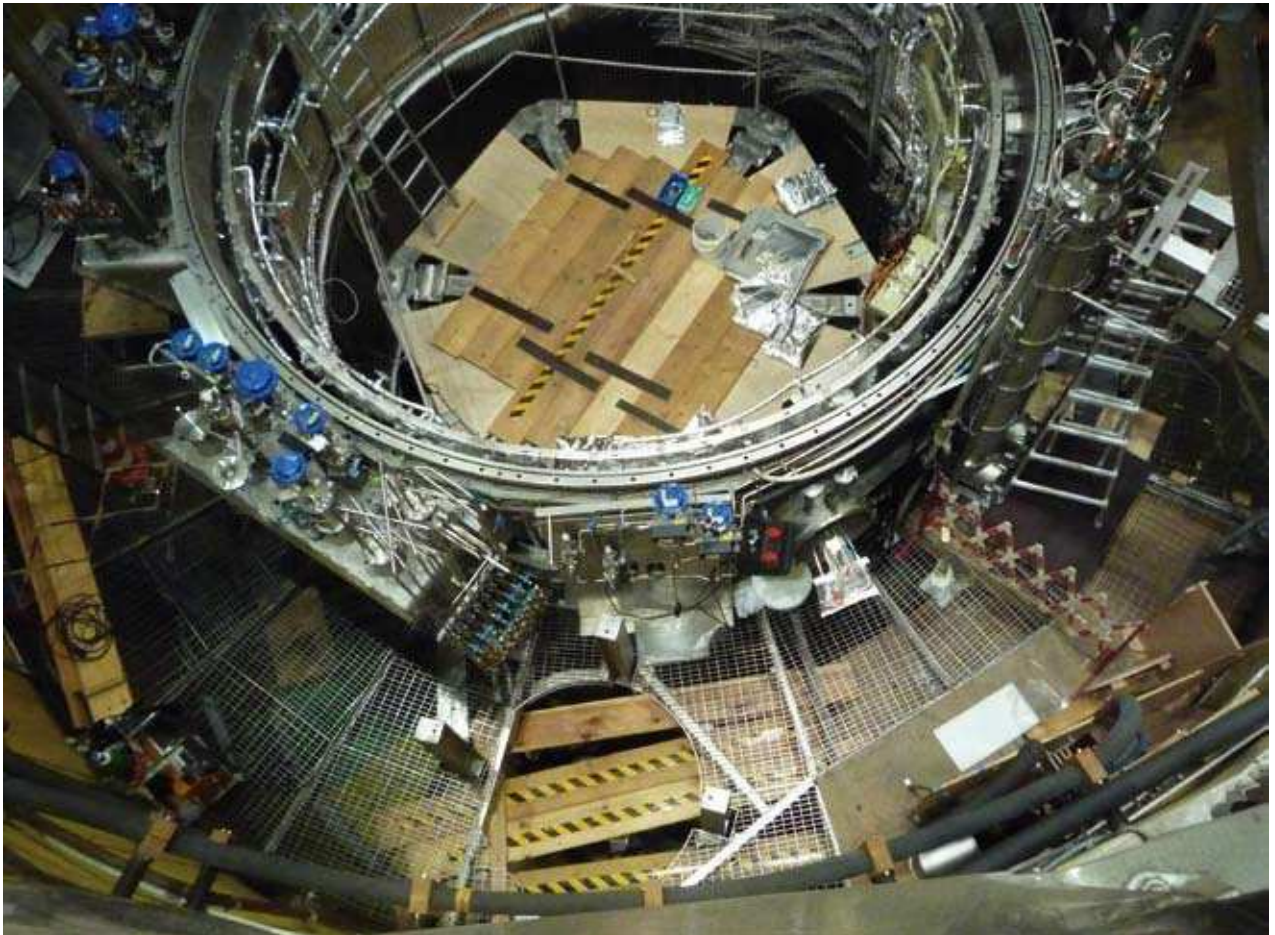
Abb. 2: TOSKA während der Anpassungsarbeiten für den Prototypentest der W7-X Stromzuführungen.
