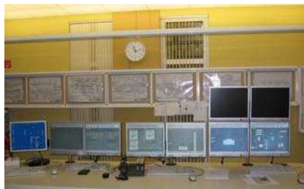
Abb. 7: Leitwarte mit neuen und zusätzlichen Monitoren.
