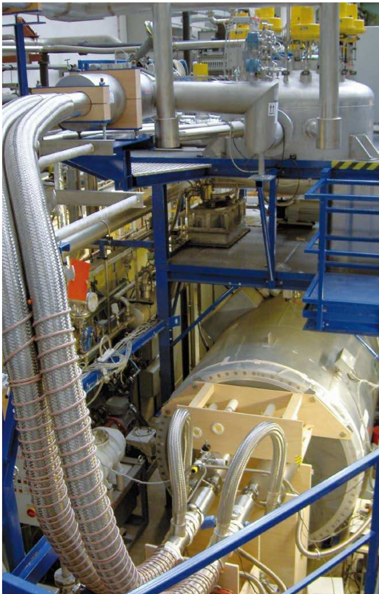
Abb. 2: Die neue ITER-prototypische Kryotransferleitung wird in TIMO-2 in Betrieb genommen.
