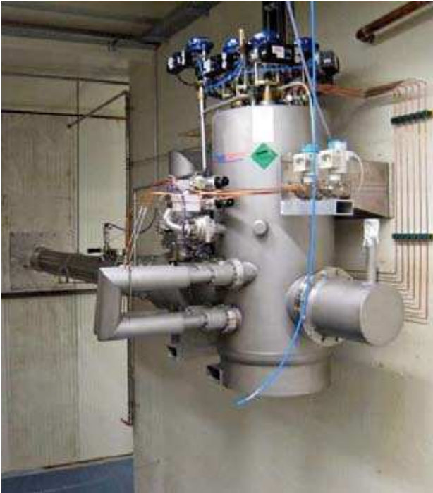
Abb. 6: Kryotransferleitung, die Ventilbox für die WGTS wurde 2008 im TLK installiert.
