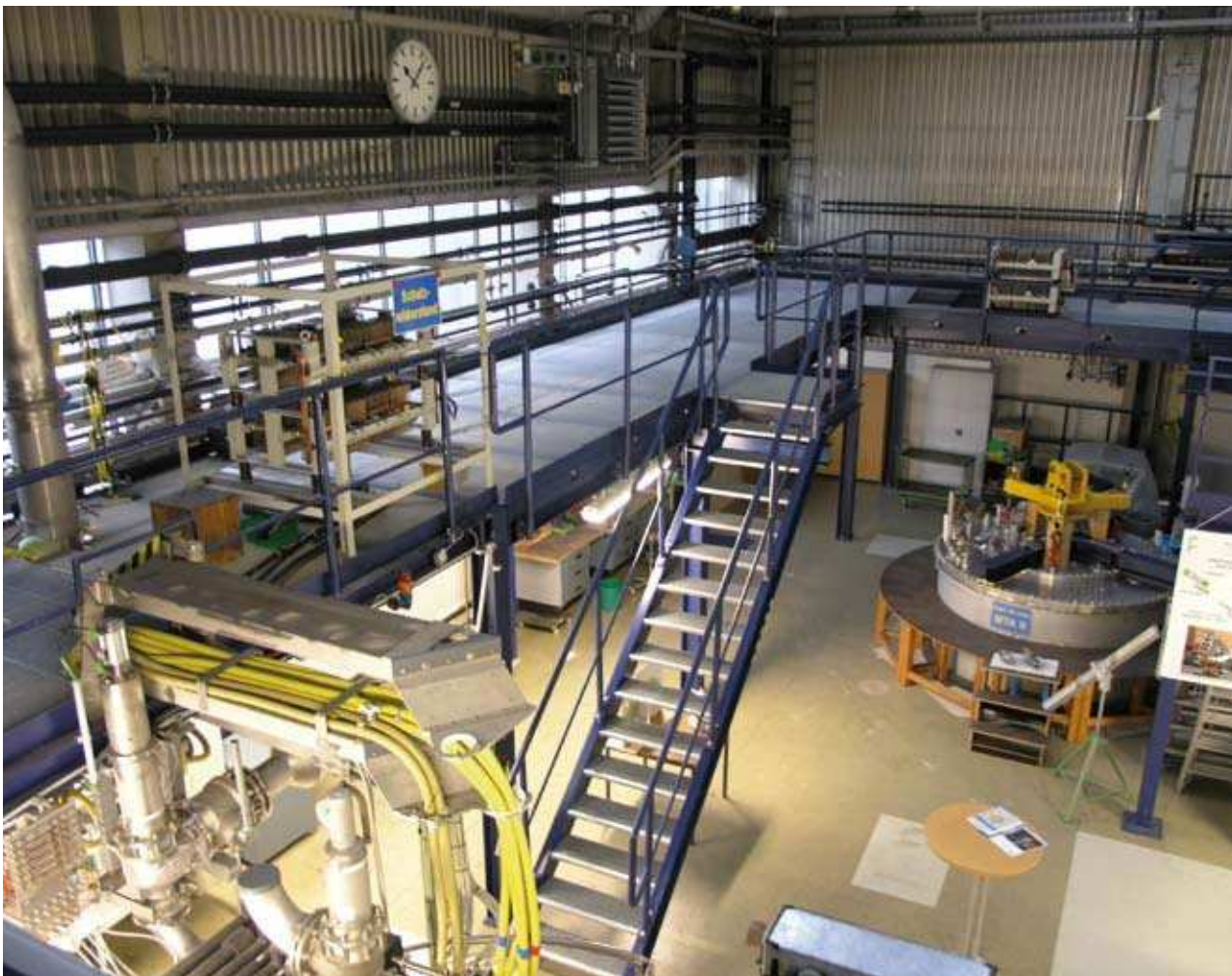
Abb. 5: Neue Arbeitsbühne im Bereich der MTA I
