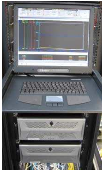
PCS7 Server und Clients für 300 W, und 2 kW-Anlage
