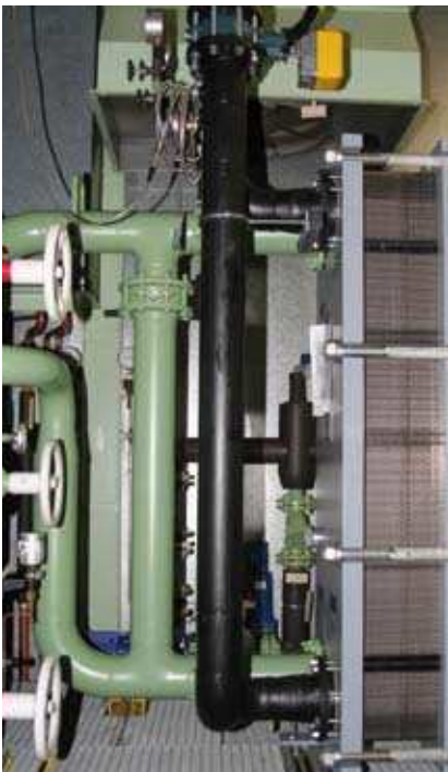
Anschluss der 2 kW-Anlage an die Rückkühlwasseranlage
