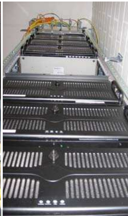
PCS7 Server und Clients für 300 W, und 2 kW-Anlage
